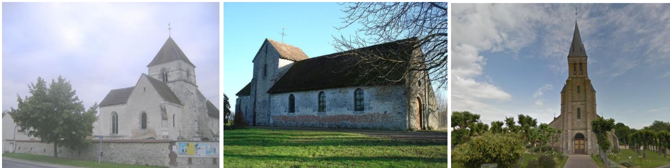
Eglise d'Euvy / Eglise de Pierre-Morains / Eglise de Pleurs
